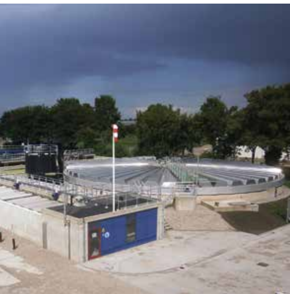
Ruimerbrug met meedraaiende overkapping ALU - diameter tank 27 m - Dronten (Nederland)
