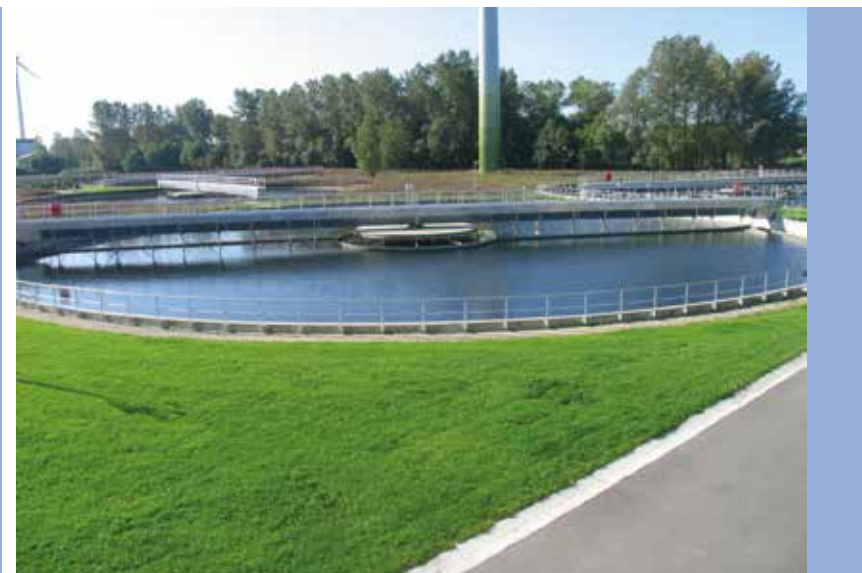
Diametrale ruimerbrug ALU kokerconstructie - tankdiameter 52 m - RWZI Brugge (België)
