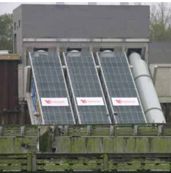
Prefab vijzelpompen/ waterkrachtvijzels op het albertkanaal aan het sluizencomplex te Ham & Olen (België) - 6 vijzels - 780 kW pompwerking - 360 kW turbinewerking - 5 m³/s - Vijzeldiameter 4,3 m - Beschoepingslengte 21,6 m
