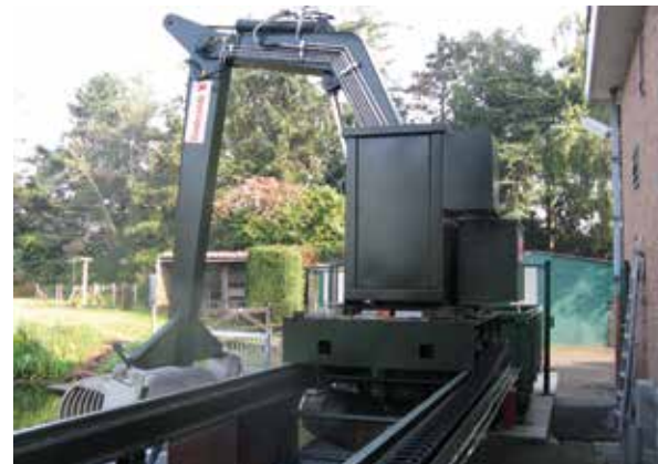
Roosterreiniger - kraan - hydraulisch - PS Ertvelde (België)
