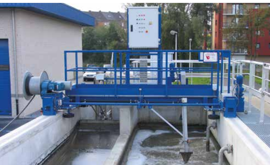
Langzandvanger met airliftsysteem Step Tubize (België)
