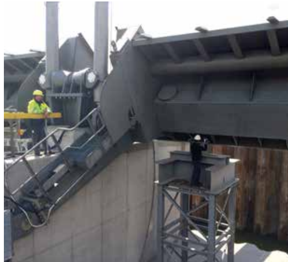
Elektromechanische uitrusting van de stuwen op het sluisencomplex te Harelbeke (België)
