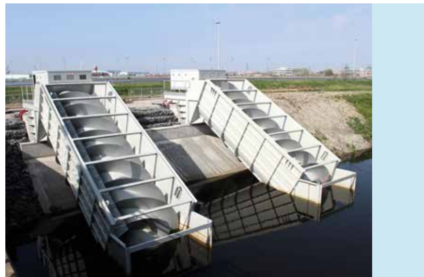
Vijzelpompen uitgevoerd als zelfdragende prefabconstructie op het Leopoldkanaal in Zeebrugge (België) - 2 vijzels - 315 kW - 5 m³/s - Vijzeldiameter 3,7 m - Beschoepingslengte 10,6 m
