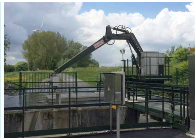
Roosterreiniger - kraan - hydraulisch - Hemiksem (België)
