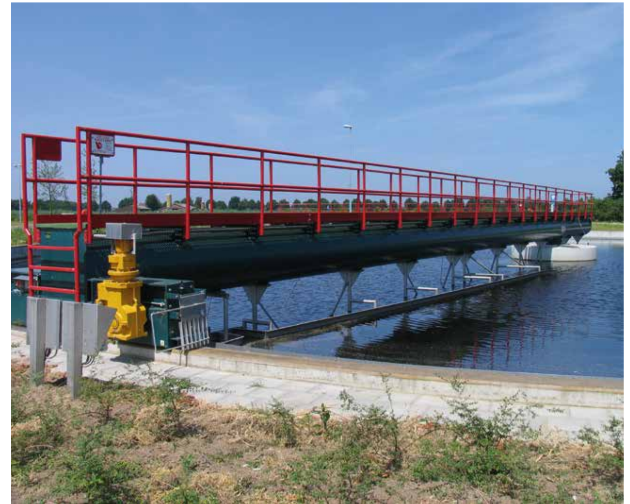
Ruimerbrug stalen buisconstructie - diameter tank 48,5 m - Aarle Rixtel (Nederland)
